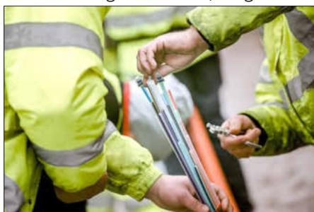
Derzeit werden im Zuge des Glasfaserausbaus der Telekom solche Speedpipe-Rohrverbände in den Großenseebacher Straßen bzw. Gehwegen südlich der Seebach verlegt.
