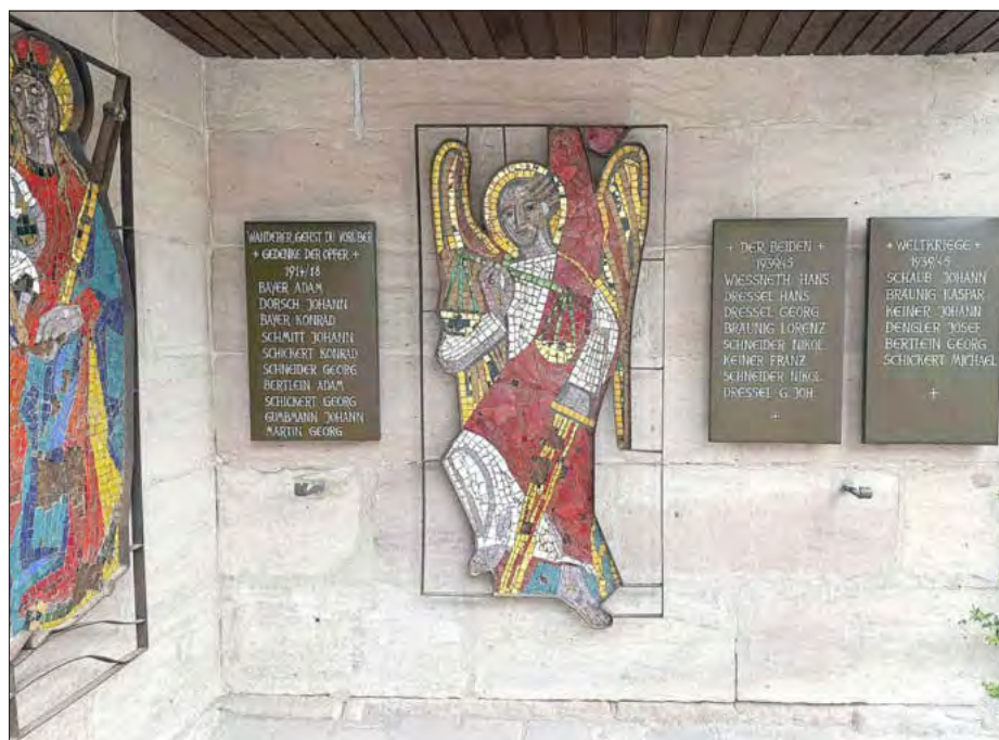
Das Kriegerdenkmal an der Kapelle in Hesselberg wurde umfangreich saniert.
