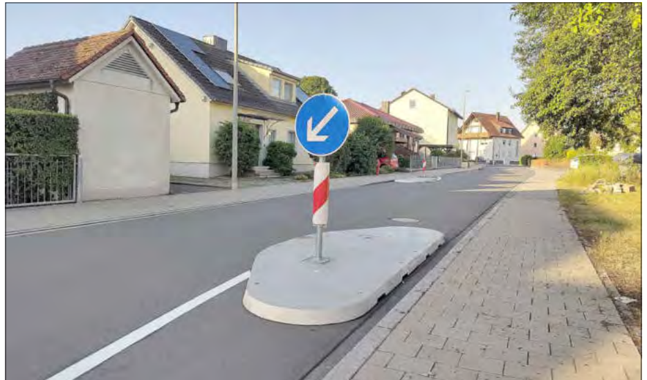
Die neuen Fahrbahneinengungen sollen zu einer besseren Einhaltung der zulässigen Höchstgeschwindigkeit von 30 km/h beitragen und damit die Verkehrssicherheit erhöhen.
