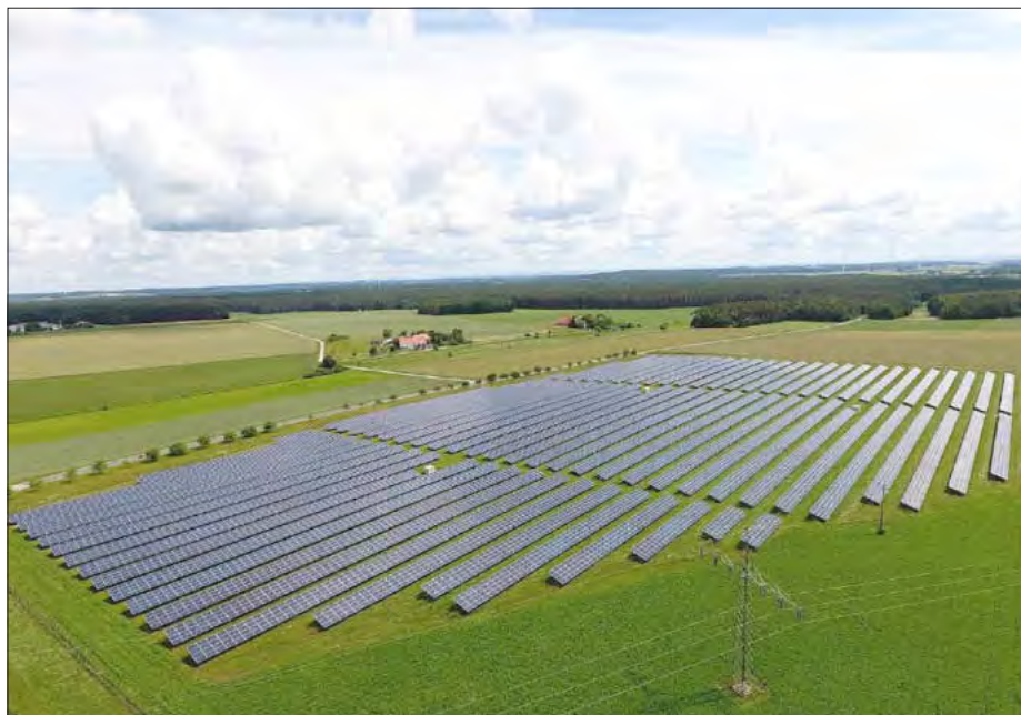
Eine moderne Freiflächen-PV-Anlage von Wust - Wind & Sonne. So könnte auch die geplante Anlage in Großenseebach einmal aussehen. Foto: Wust – Wind & Sonne GmbH & Co. KG
