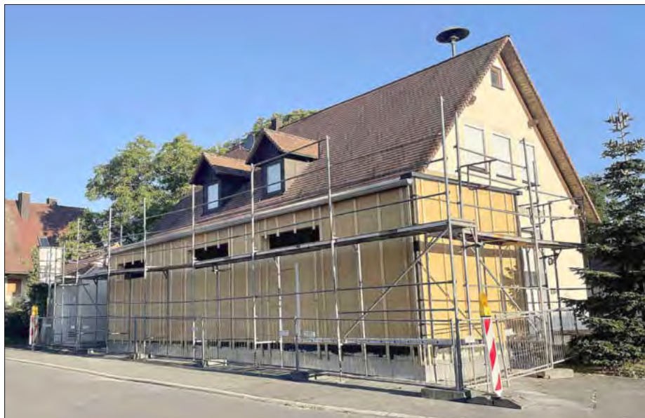
Der Anbau am Gerätehaus der Feuerwehr schließt direkt an das Bestandsgebäude an.
