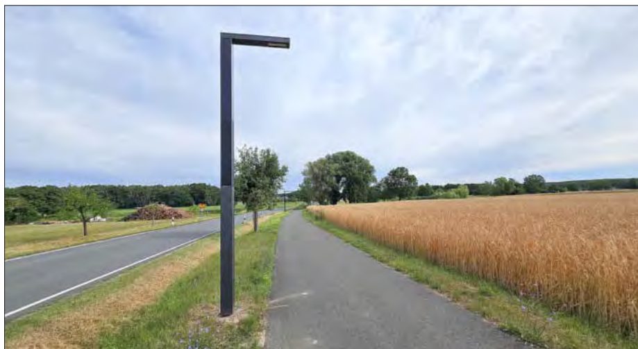
Insgesamt wurden zwischen den beiden Ortsteilen 18 Leuchten aufgestellt, bei denen sich als Besonderheit die Solarzellen im Mast (statt auf einem separaten Panel) befinden.
